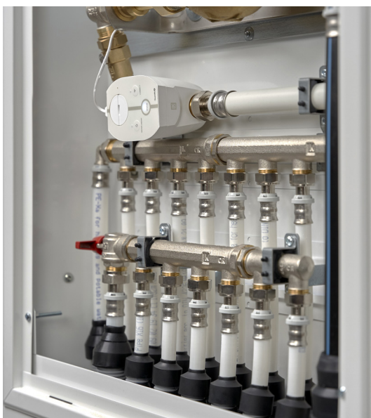
Vannstopper montert i skapet.
